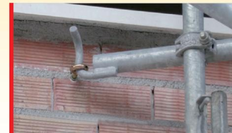
Fixation des anneaux sur les joints en cas de briques (cheville en PVC)
